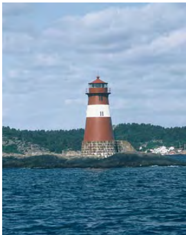
YTRE MØKKALASSET (nedlagt fyr) sett fra SE FOTO: Kartverket (2004)
