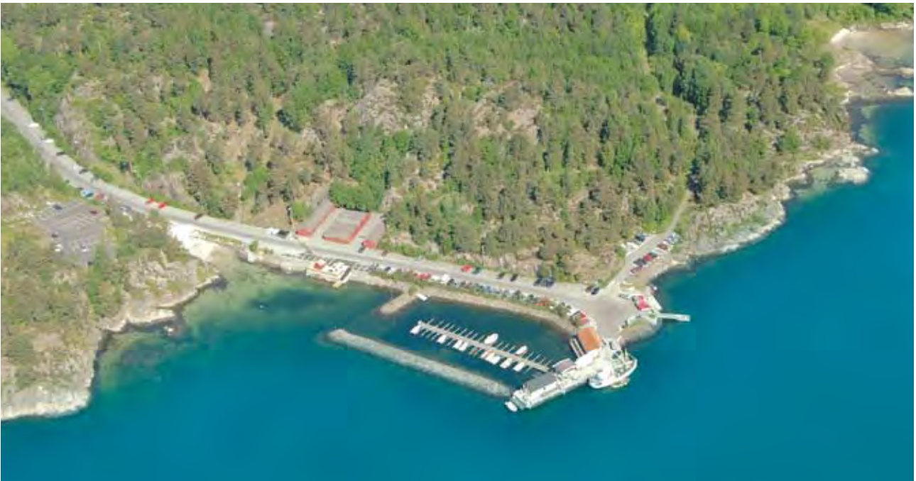
HAGEFJORDBRYGGA sett fra SE (2004)
