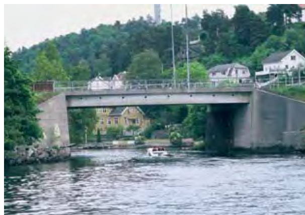
Brua over STRØMMEN til Hisøy, sett fra SW FOTO: Kartverket (2004)
