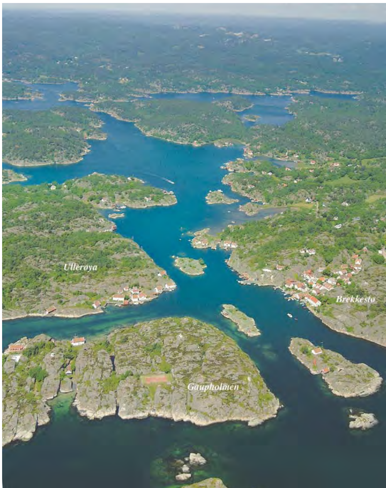
BREKKESTØ, Blindleia i bakrunnen, sett fra SE (2004)
