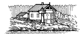
Stangholmen (nedlagt) ( 58^{\circ} 42,5'N 09^{\circ} 15,0'E ) 8,5 m høyt hvitt trehus på betongsøyle. Lykt ved siden av fyret, lysets høyde 9,0 moh. Sett fra SE.
