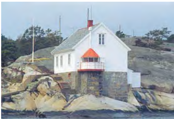
STRØMTANGEN LYKT sett fra SE (1992)
