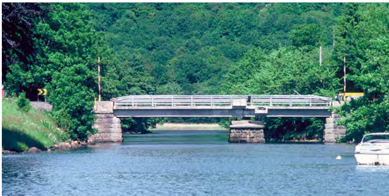
Svingbrua ved STRAUMEN, sett fra SW (2004)
