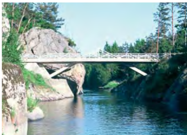
Brua (6) over KASSENKANALEN sett fra W (2004) FOTO: Kartverket
