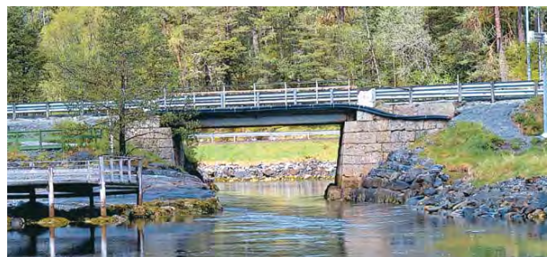
DRAGSUNDET, Storffjorden, sett fra S (2002) FOTO: Kartverket
