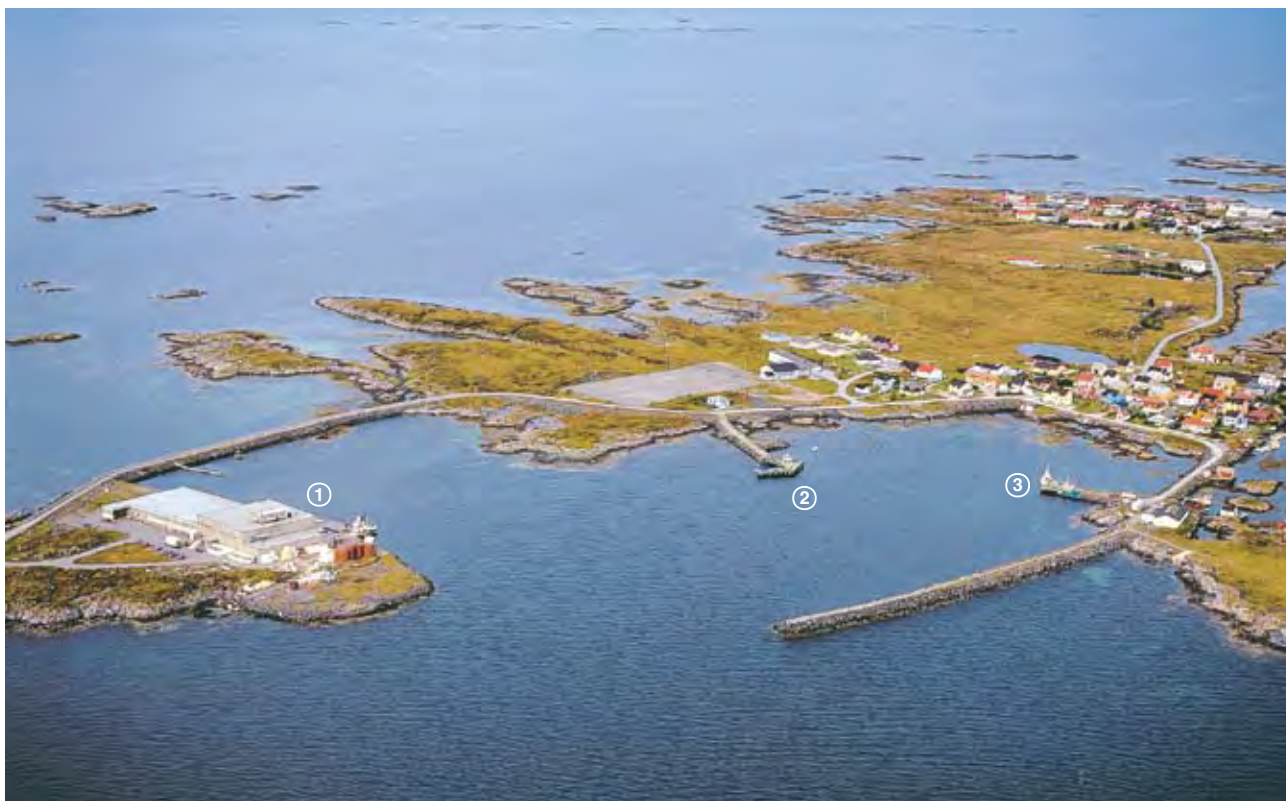
INNVEIEN sett fra E (2002)
