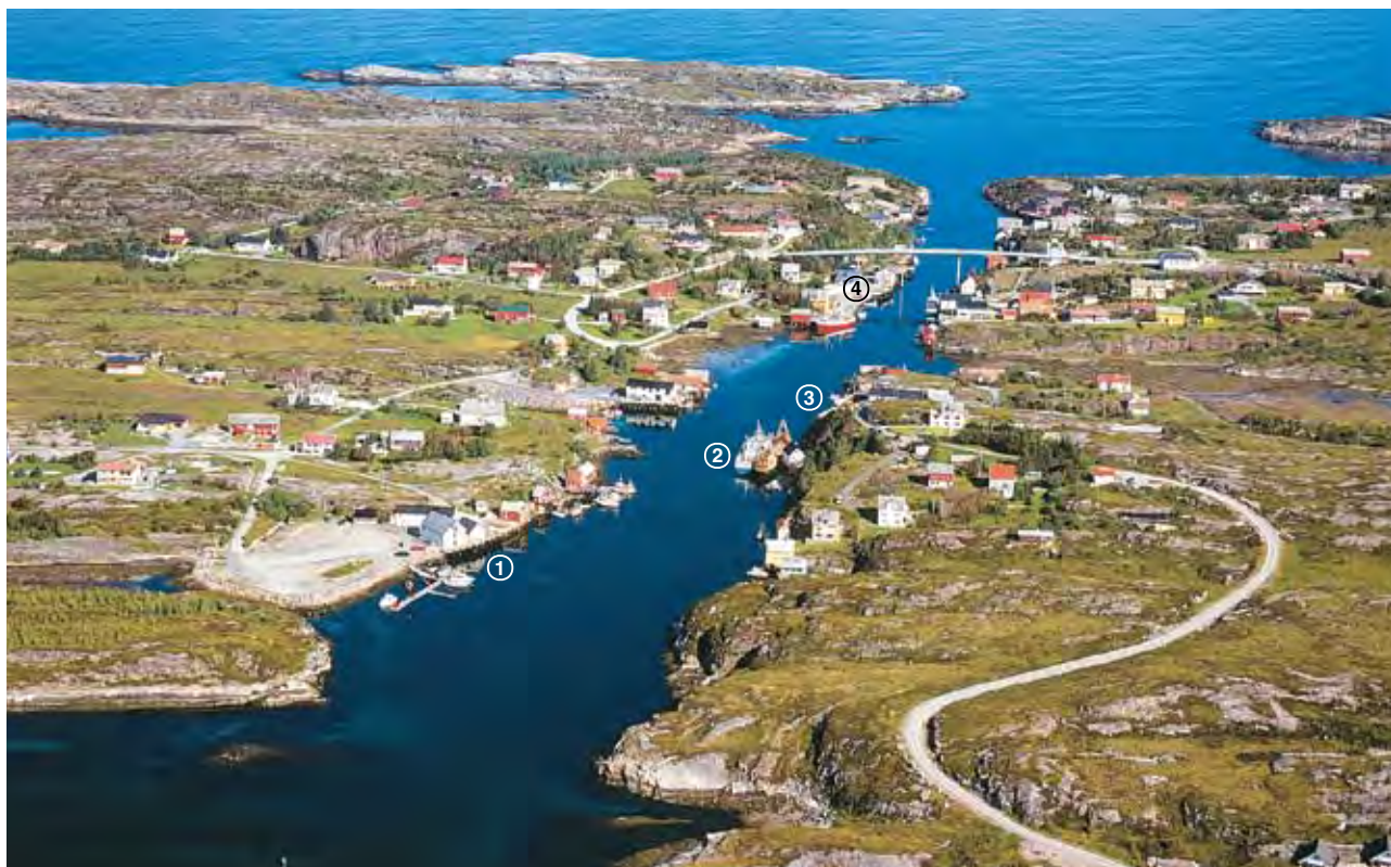
SVEGGESUNDET sett fra SSE (2002)
