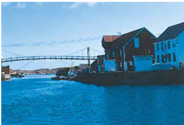
Hengebrua ved BOGØYVÆR sett fra N (2002) FOTO: Kartverket
