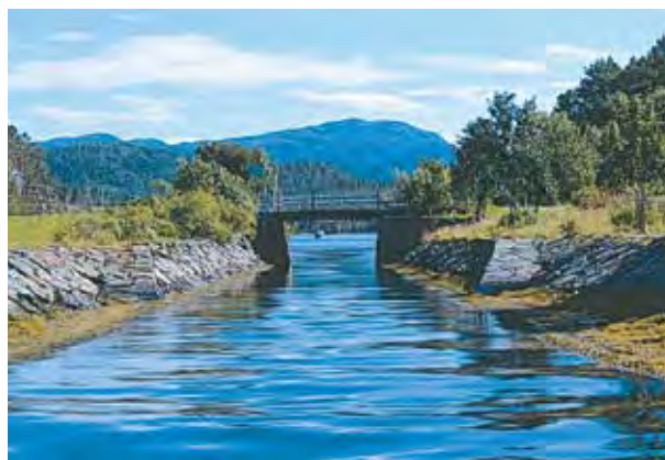
NÅLSUNDET bru, sett fra NW (2002)
