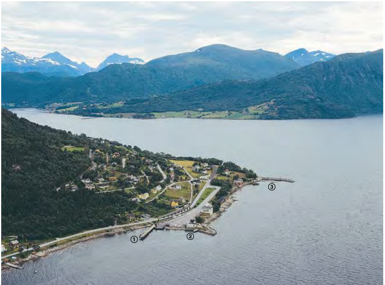
ÅFARNES sett fra NE (2002)
