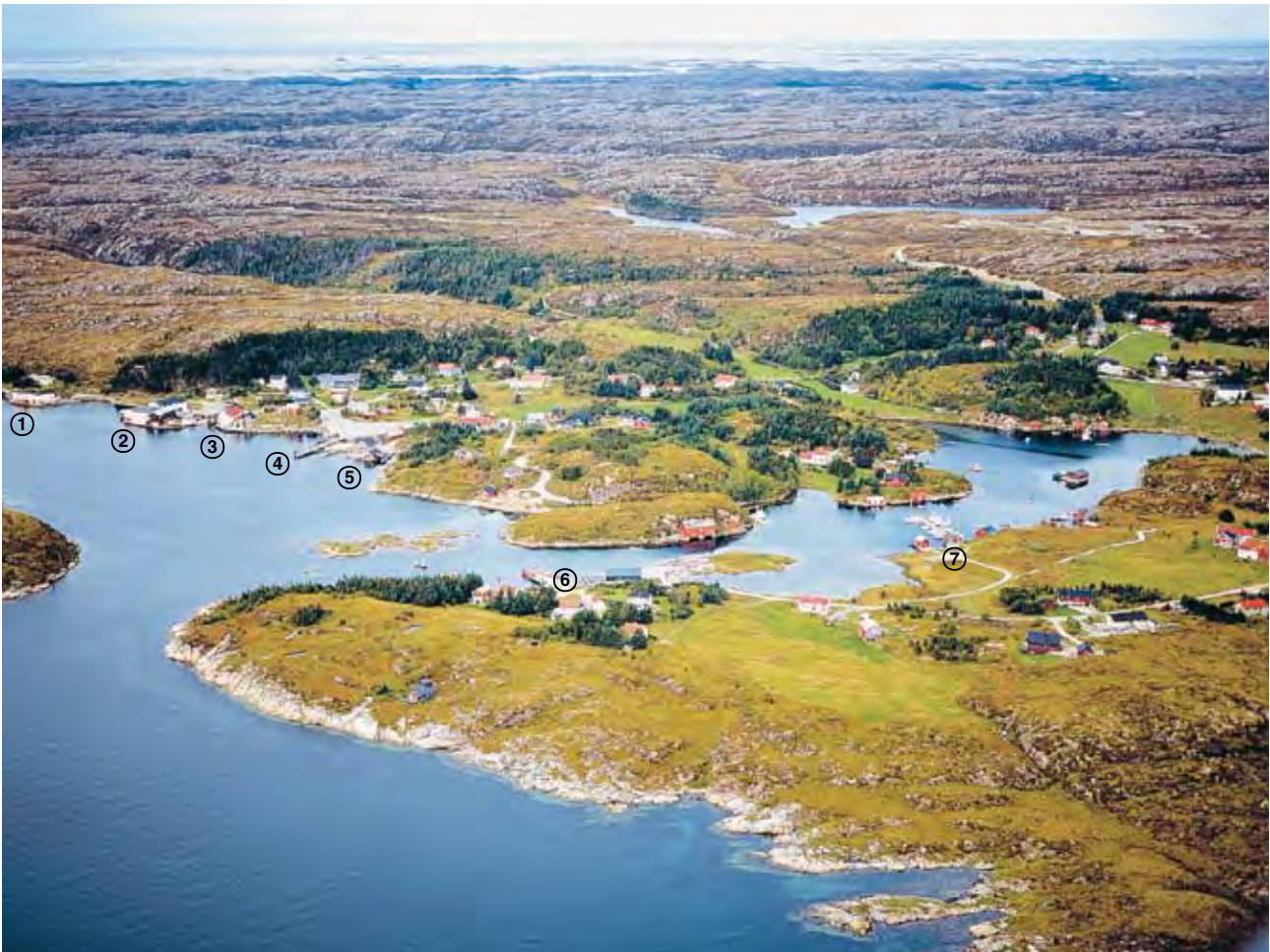
FLATVAL sett fra SE (2002)
