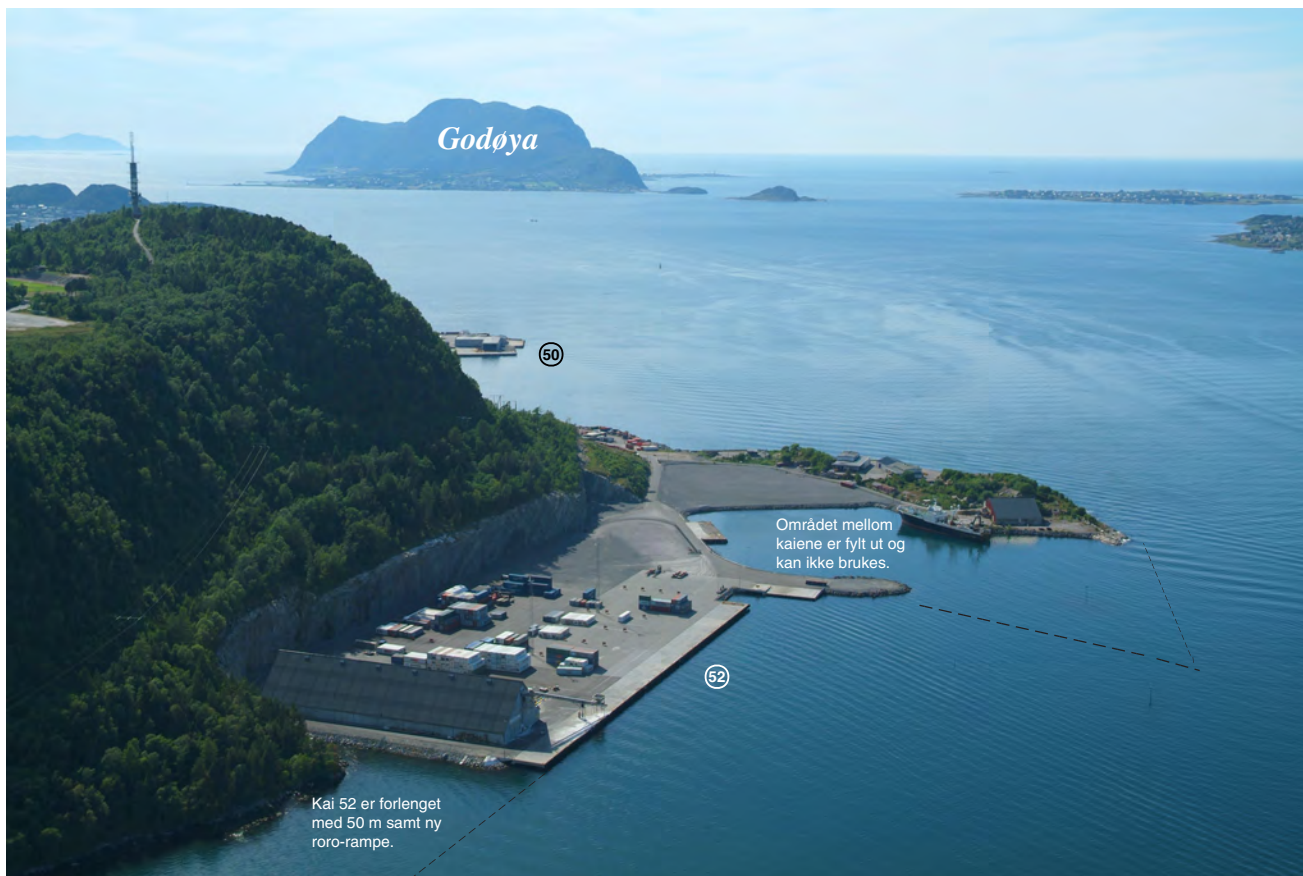
FLATHOLMEN, sett fra E (2007)
