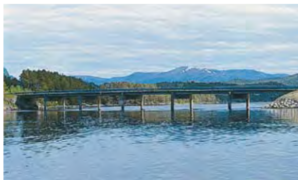
Brua mellom Hestnes og Kjøløya (2002)
