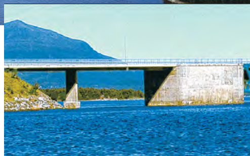
SEILLØPET sett fra E (2002) FOTO: Kartverket
