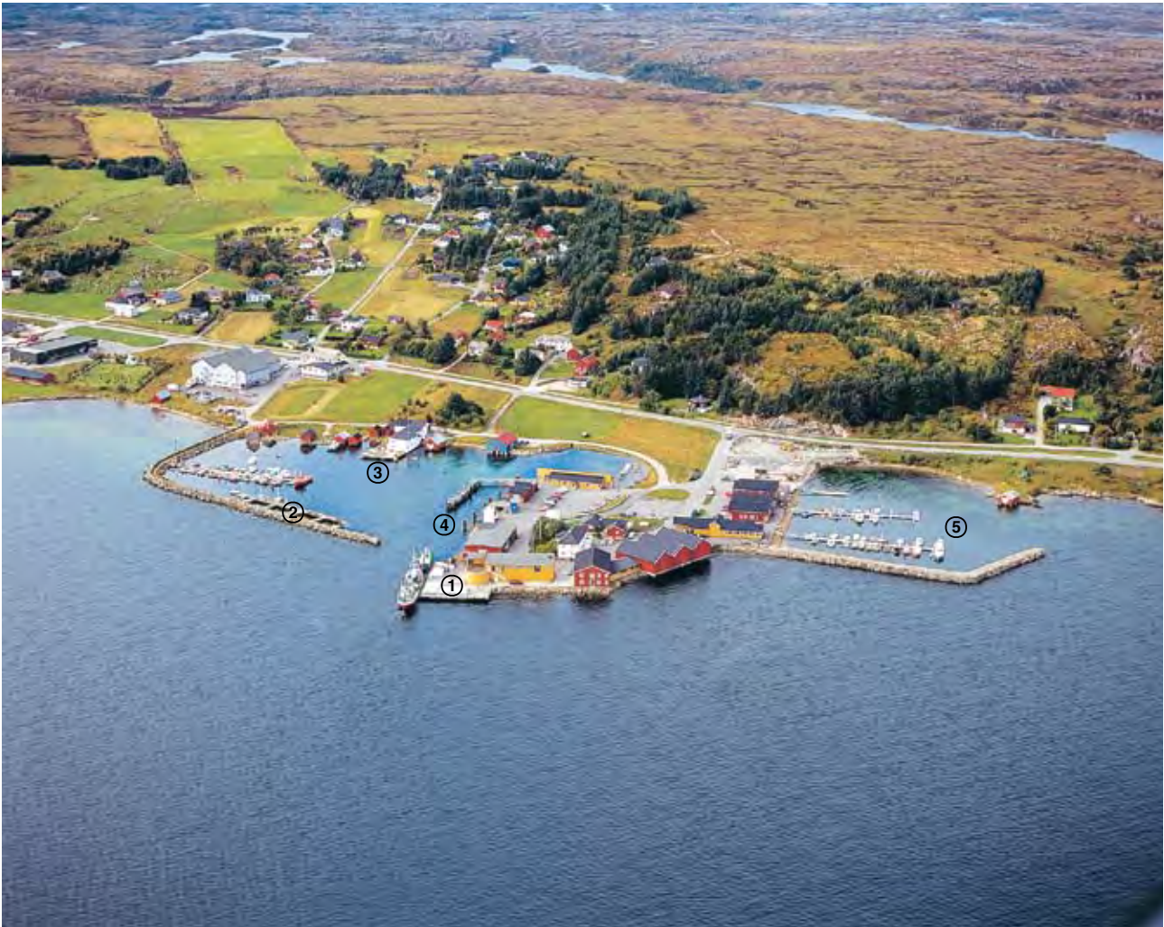
SISTRANDA sett fra E (2002)
