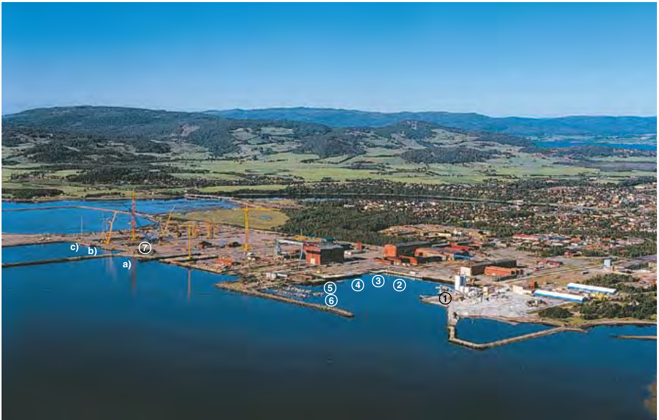
VERDALSØRA sett fra SW (2002)
