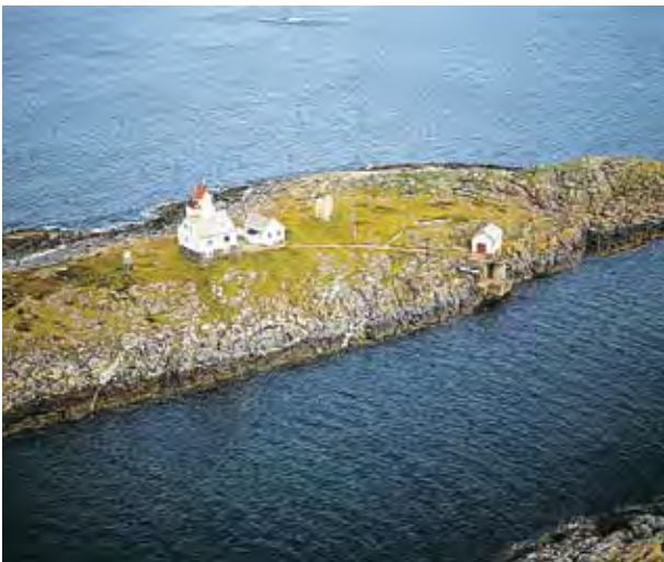
SKALMEN FYR sett fra SE (nedlagt og slukket) FOTO: Eiliv Leren
