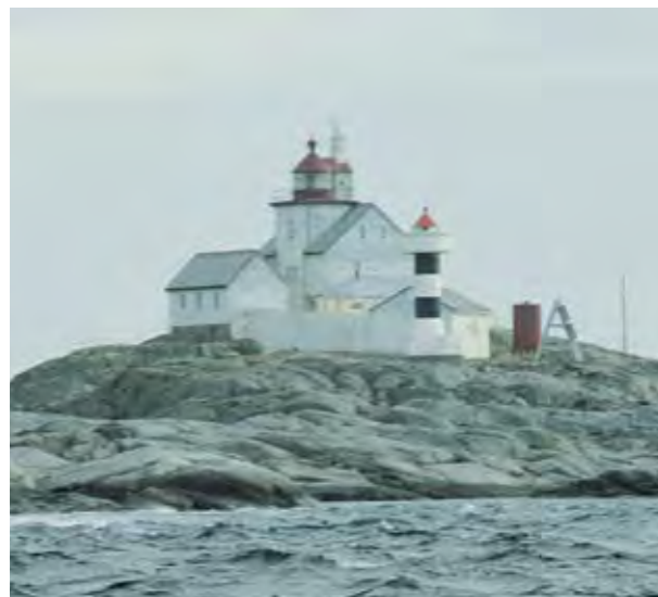
FINNVÆRET FYR (nedlagt) lykt, sett fra SE (2002)
