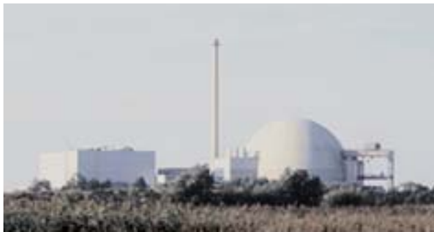
Unterweser (Esenshamm) Nuclear Power Plant
